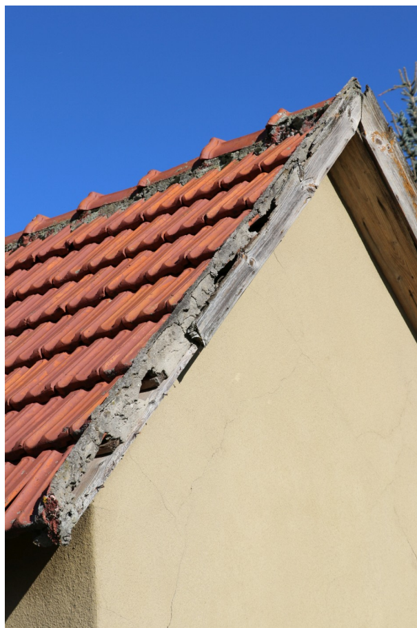
fot. 11: Kapliczka domkowa - widoczne uszkodzenia i ubytki desek osłonowych krawędzi dachu.
