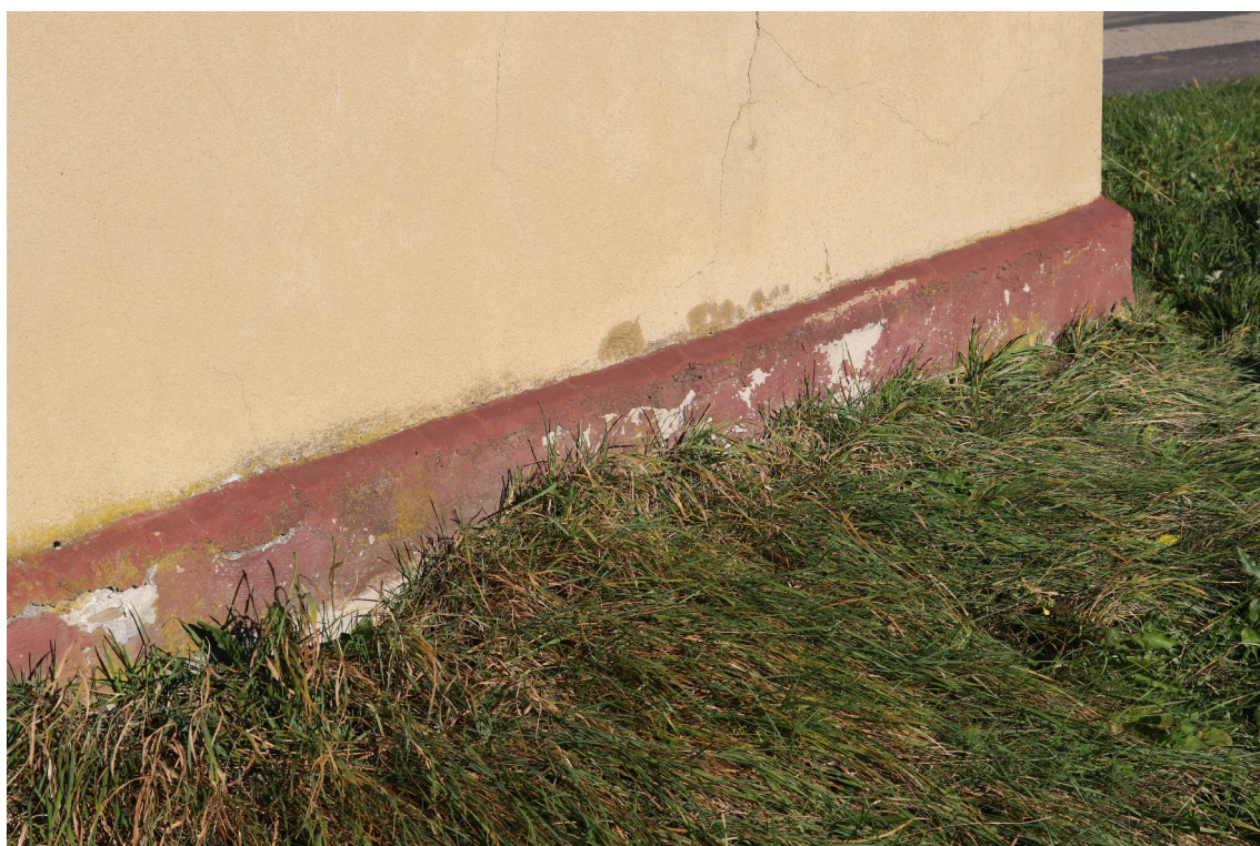
fot. 13: Kapliczka domkowa - widoczne uszkodzenia tynku cokołu elewacji tylnej oraz nalot biologiczny.
