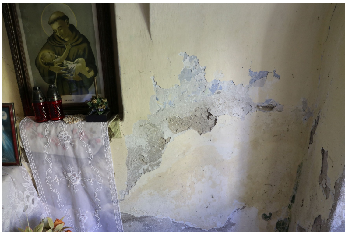
fot. 15: Kapliczka domkowa - widoczna degradacja tynku ściennego dolnej partii ściany.
