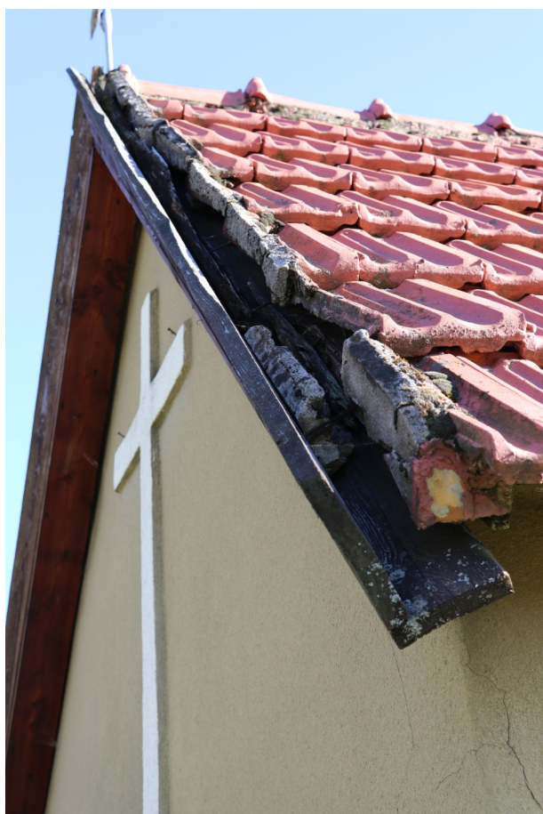
fot. 10: Kapliczka domkowa - widoczne odkształcenie desek osłonowych krawędzi bocznej dachu.
