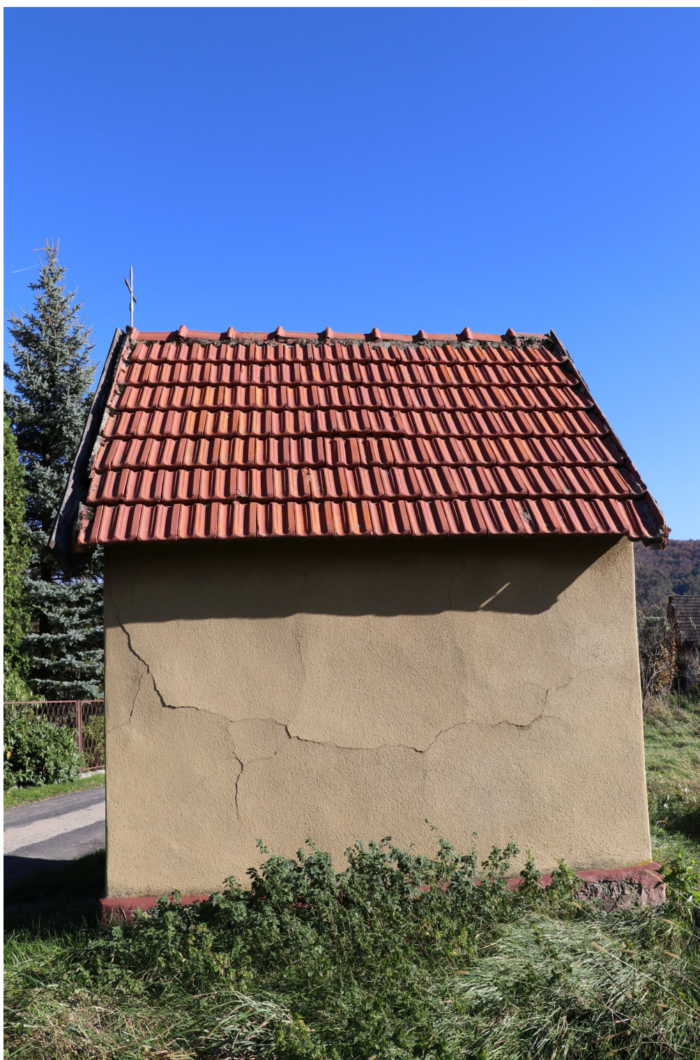
fot. 9: Kapliczka domkowa - widoczne spękania tynku wtórnego cementowego na elewacji bocznej.
